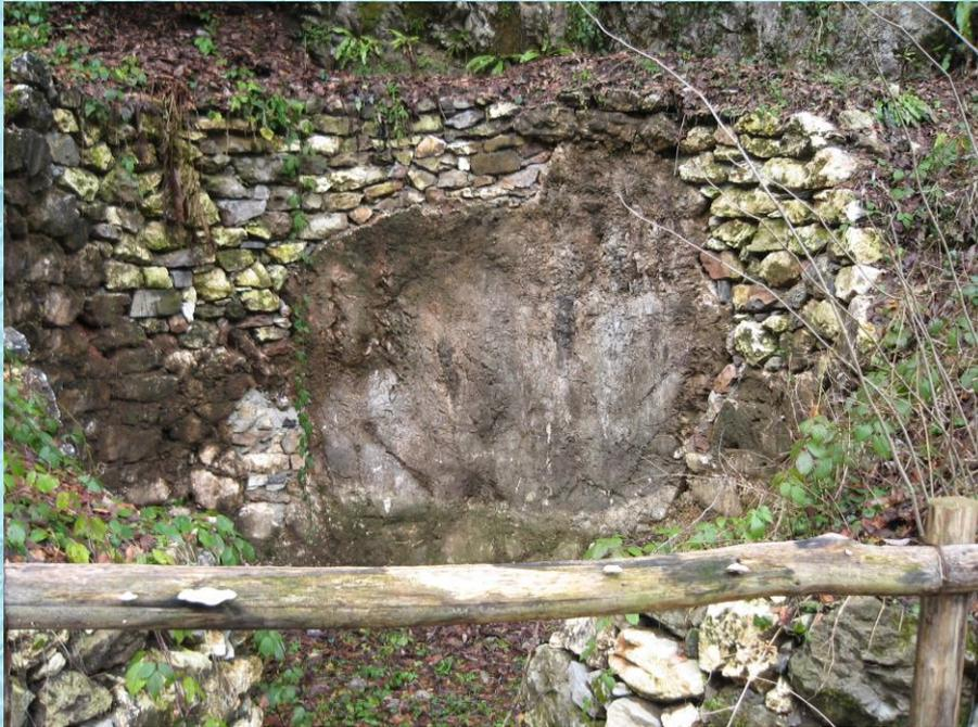
Un tempo , quando non esisteva il cemento, la calce era il materiale di base per l'edilizia e veniva prodotta in speciali fornaci in muratura dalla forma cilindrica , scavate nel terreno, **le calchere** , di cui esistono ancora i resti sparsi sul territorio .
